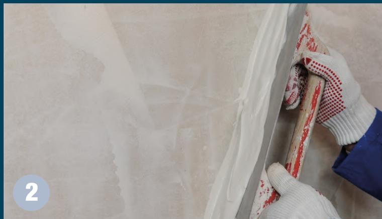
Logo após a amassadura, aplicar com uma colher ou uma taloça metálica (liçosa), dependendo do fim a que se destina.
