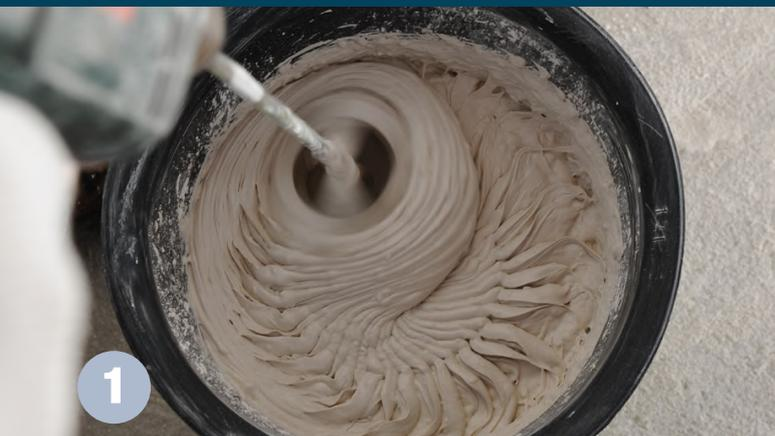
Num caldeiro limpo, com água limpa, deitar o produto lentamente, até à saturação (equivalente a cerca de 2,2 kg de massa em 1 l de água).
